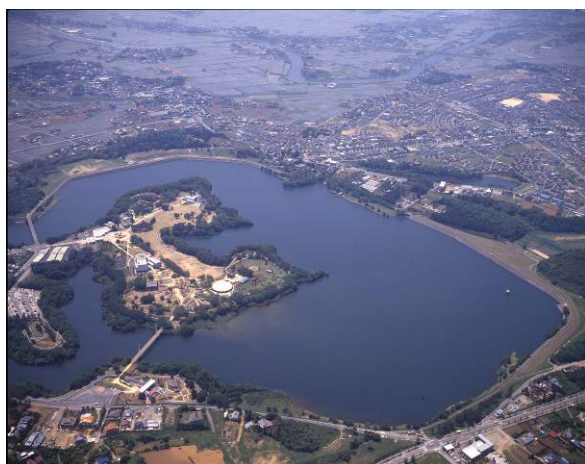
山倉ダム(千葉県市原市)
