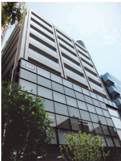
2016年9月に投資実行した複合型高齢者施設「勝どき駅前複合ビル」
