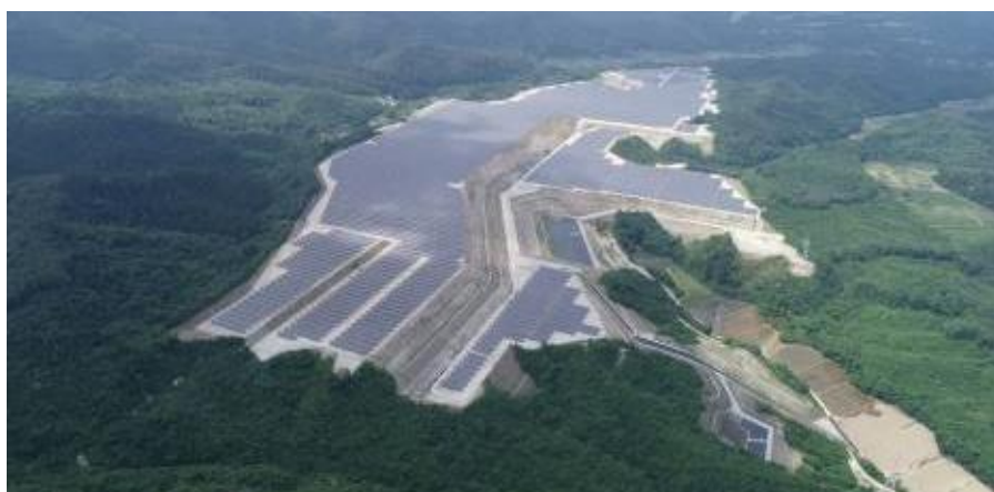
宮城・黒川メガソーラー発電所
