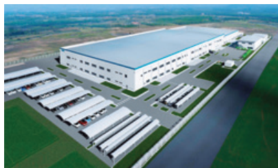
TOTOタイランド第3工場 (仮称) の外観イメージ
