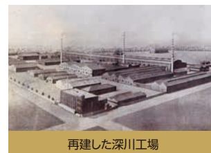
再建した深川工場
