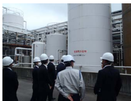
新入社員研修の一環で環境設備の見学会を実施（三重工場）
