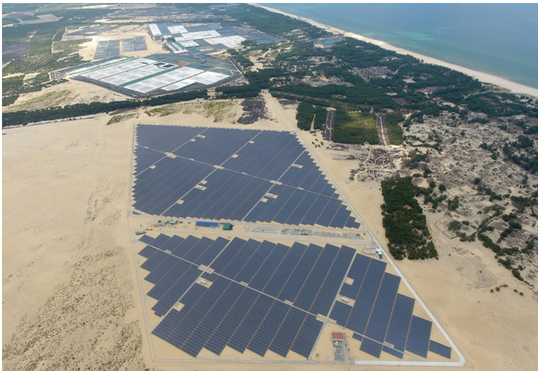
運転を開始した太陽光発電所
