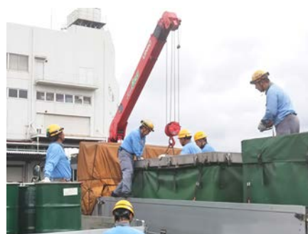
PCB廃棄物搬出作業
