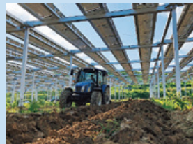
一関市吉高太陽光発電所
