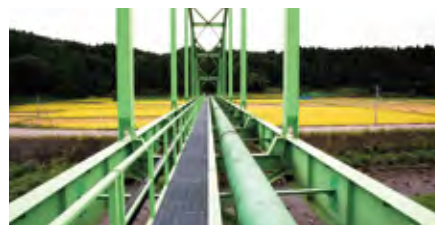
新潟・仙台間ガスパイプライン
