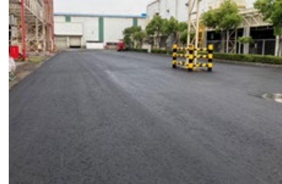
廃PETを活用した高耐久アスファルト改質剤の海外展開に向けて、台湾で試験施工を実施
