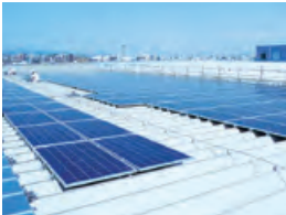
大阪中央工場屋上
