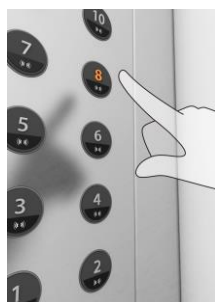
オフィス用エレベーターは 手をかざして使用する非接触ボタンを採用
