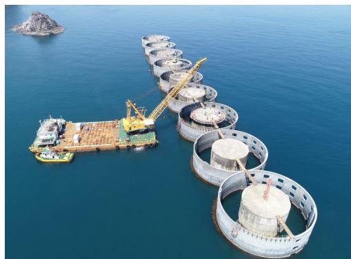
柴山港柴山地区外防波堤(西)本体性能維持工事(兵庫県)
