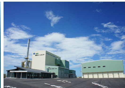
(仮称)有明クリーンセンター建設工事(熊本県)
