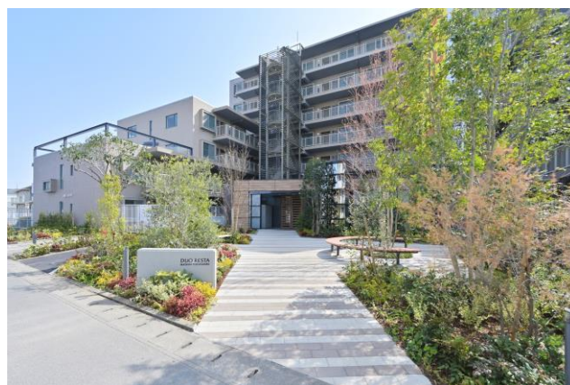
After：外観・アプローチ
