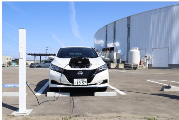
▲山形BPOパークの充電設備
