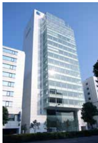
ワールド北青山ビル
