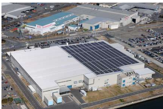
名古屋第一工場 750kW発電設備
