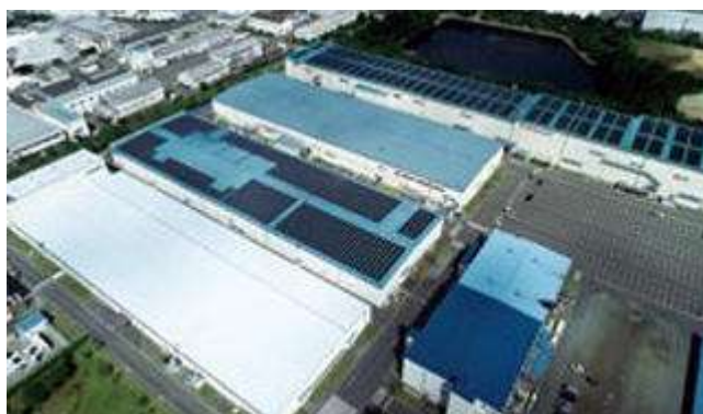
西神工場 1,444kW発電設備
