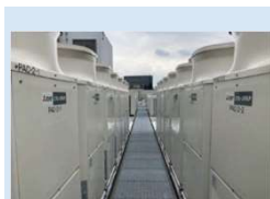
空調設備の更新 (Daiwa銀座ビル)
