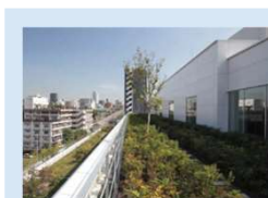
屋上庭園の設置 (Daiwa麻布テラス)
