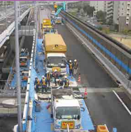
高速道路の補修工事
