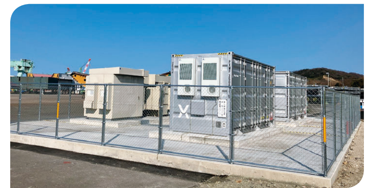
今治造船（株）西条工場東ひうち事業部蓄電池設置工事（愛媛県）
