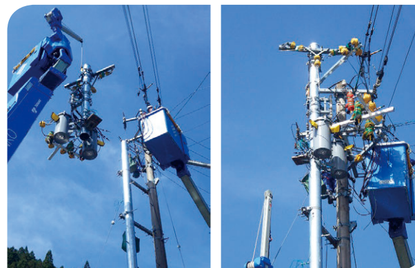
プレハブ工法による施工風景
