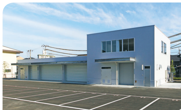
本店社屋 災害対策棟 防災用備品や非常食を常備。大規模災害時には敷地を緊急資材置場、緊急応援車両置場、復旧作業応援部隊のテント設置場所としても利用可能
