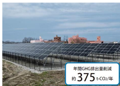
新潟浄化センター【新潟県】
