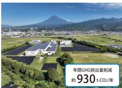
東部浄化センター【静岡県富士市】
