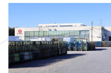
Kasumi Sakura Distribution Center (Land)
