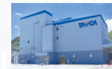
熊山工場第4工場
