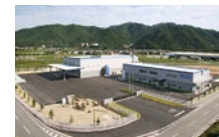
熊山工場 (左側:工場棟、右側:事務所・研究棟)
