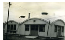
大阪工場研究室の建屋完成 (1958年3月1日)
