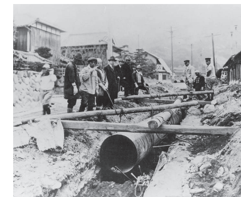
送水管布設工事(大正～昭和初期) 出典：神戸市水道局 ※写真の送水管製造メーカーは不明
