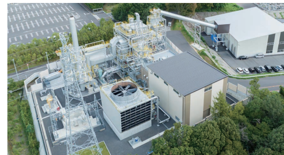
美濃加茂バイオマス発電所(岐阜県)
